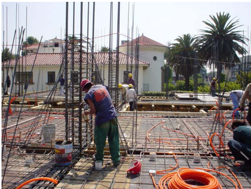
Fotografía 24. Cuadrillas de trabajadores con y sin casco.
