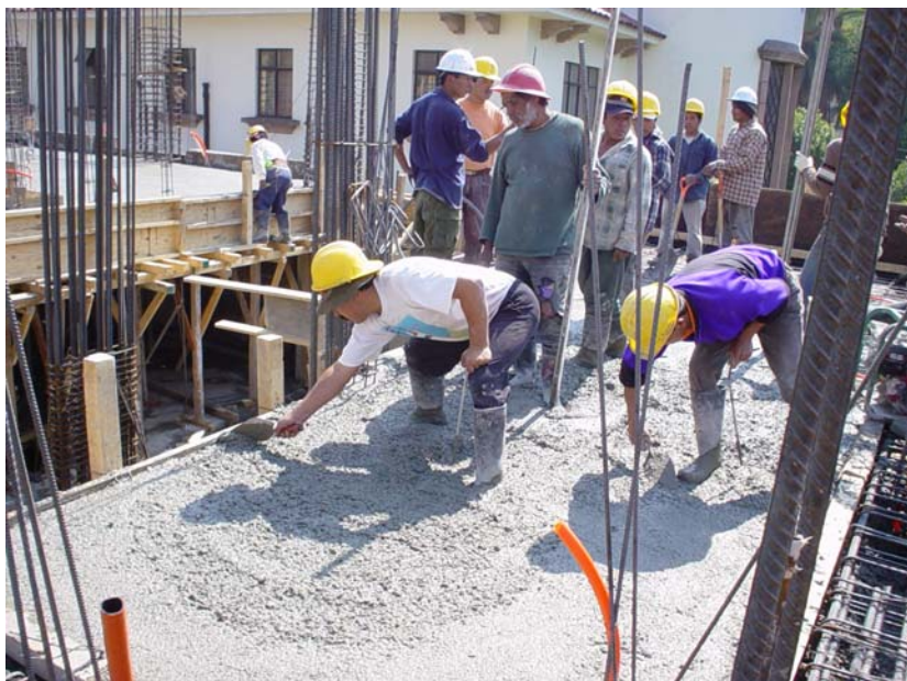
Foto 8. Colado de traves y losa.
