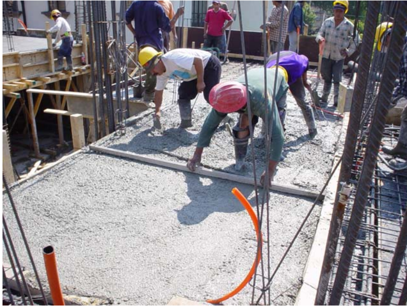
Foto 9. Nivelado de Losa
