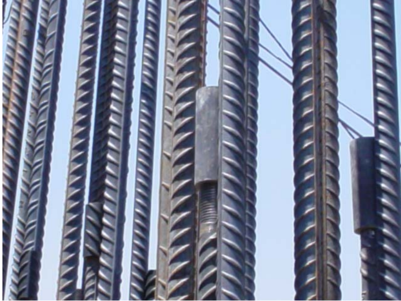
Foto 15. Coples de unión en columnas.
