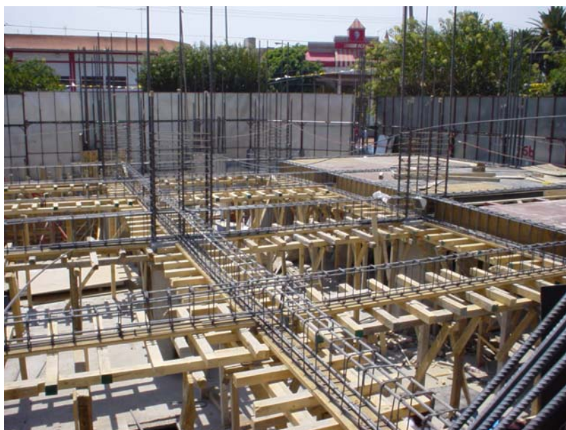
Foto 3. Armado y Cimbrado de Trabes y Losa
