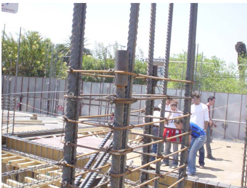
Foto 14. Coples de unión en columnas.
