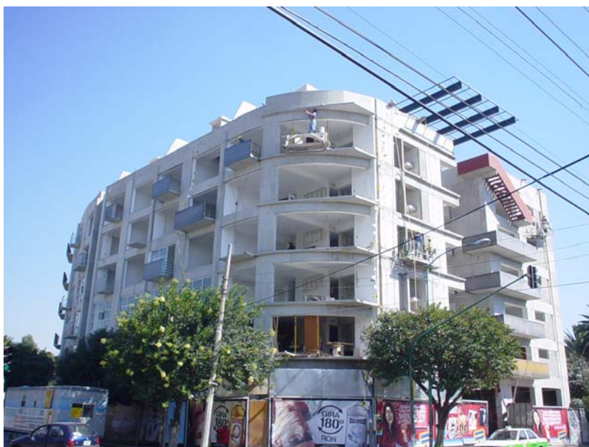
Foto 18. Inmueble con la obra negra terminada.
