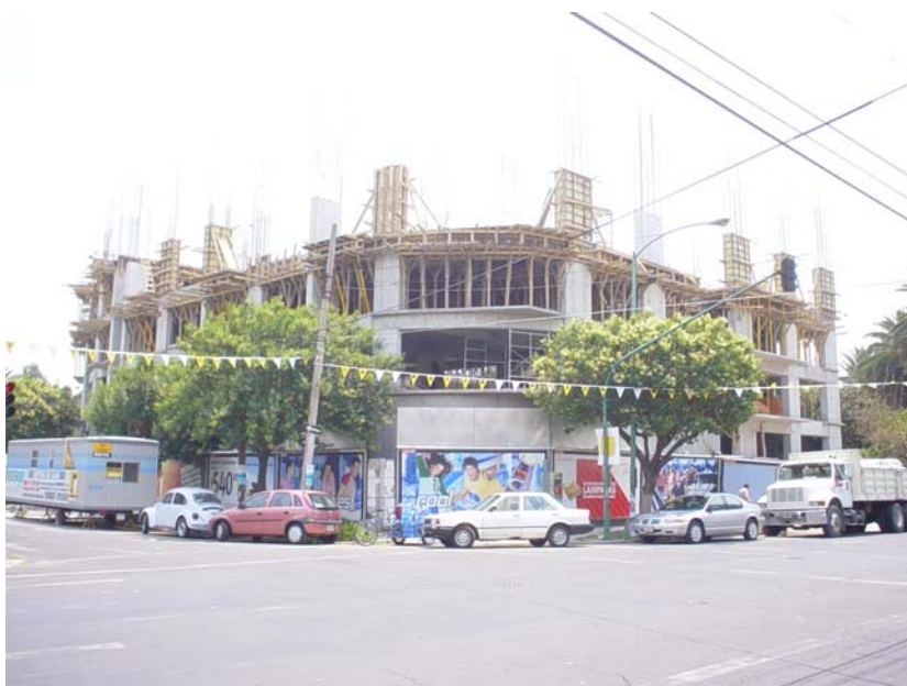
Foto 16. Estructura hasta el 3° nivel.
