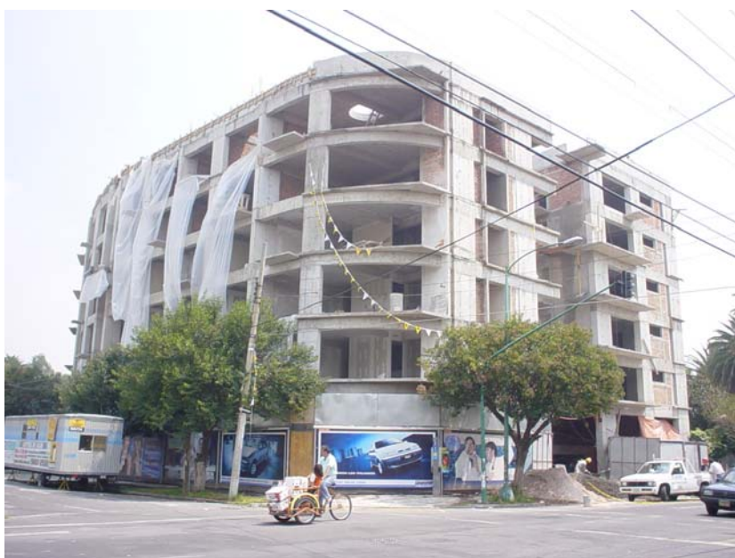
Foto 17. Estructura hasta el 6° nivel.
