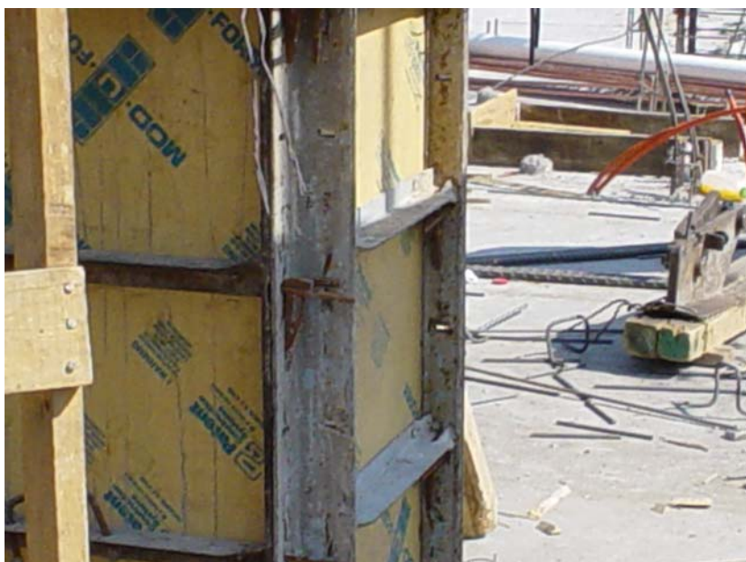
Foto 2. Cimbrado de Columnas.
