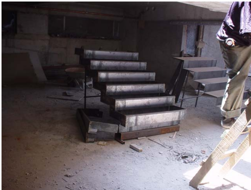
Foto 11. Cimbra metálica para escaleras.
