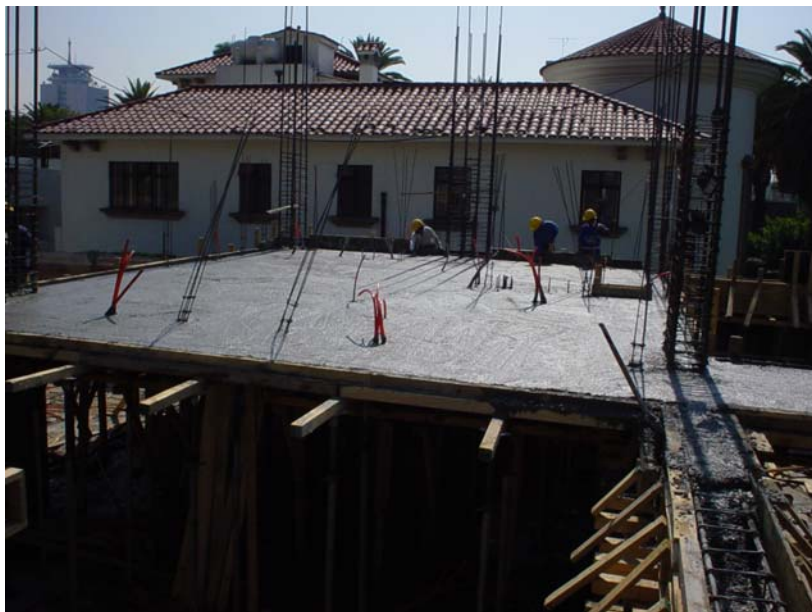
Foto 10. Terminado final de losa.
