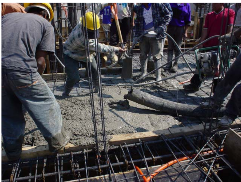
Foto 7. Colado de traves y losa.
