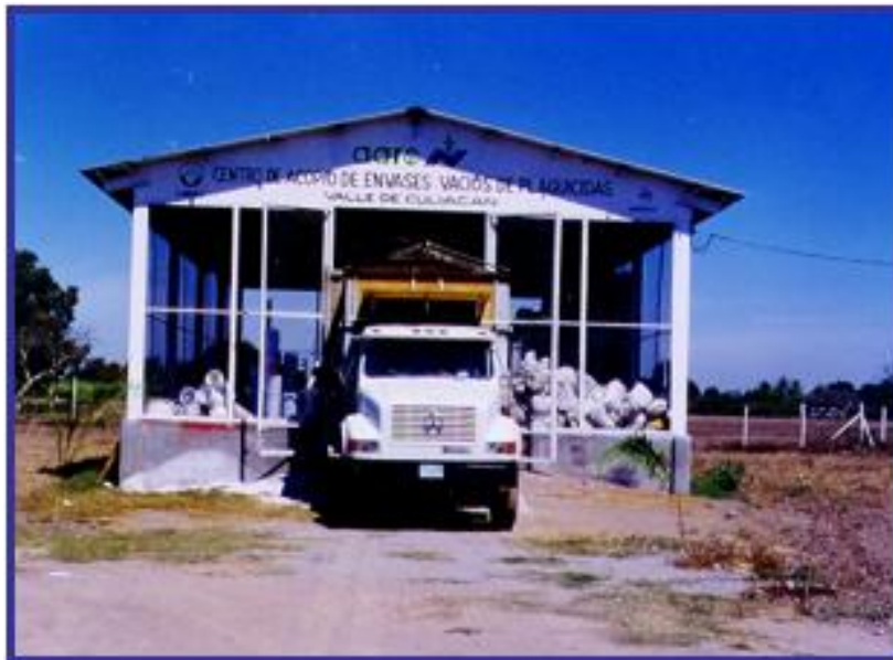
FIGURA 2.10 Centro de Acopio Temporal
