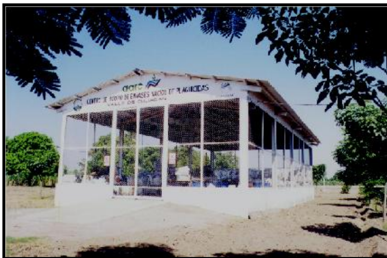
FIGURA 2.11 Centro de Acopio Temporal
