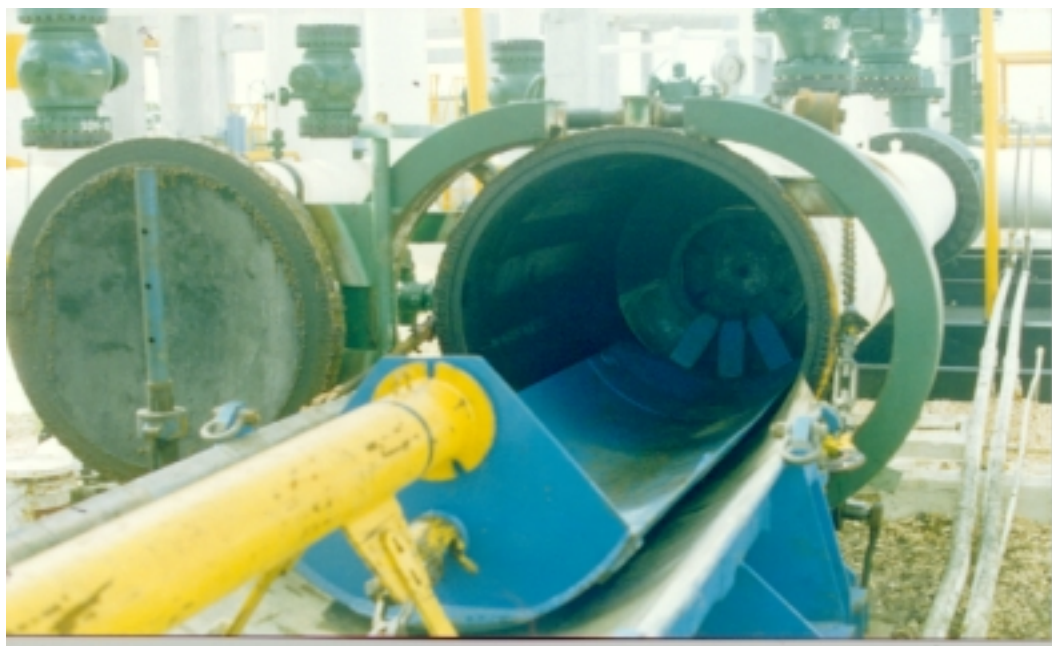
FIGURA No. 85 EQUIPOS HIDRÁULICOS EN OPERACIÓN EMPUJANDO UN DIABLO INSTRUMENTADO DE FLUJO MAGNETICO AL INTERIOR DE LA TRAMPA LANZADORA
