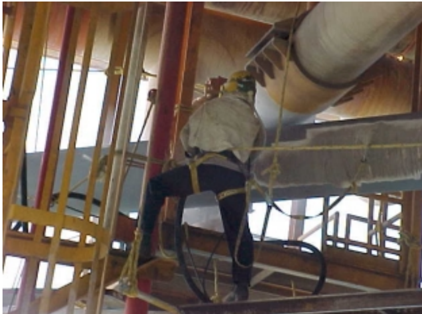
FIGURA No. 55 LIMPIEZA CON CHORRO DE ARENA DE UN DUCTO ASCENDENTE.
