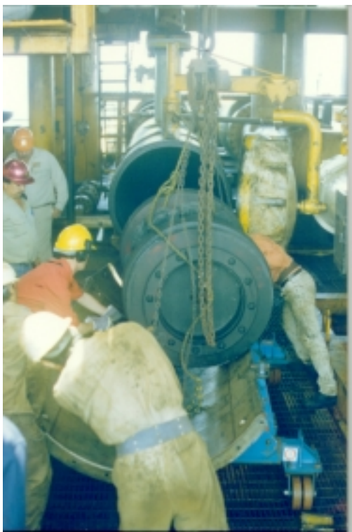
FIGURA No. 83 CORRIDA DE DIABLOS DE LIMPIEZA EN PLATAFORMAS. A LA IZQUIERDA EN MANIOBRAS DE INTRODUCCIÓN A TRAMPA LANZADORA; A LA DERECHA SE OBSERVAN LOS RESIDUOS ARRASTRADOS DURANTE LA CORRIDA.
