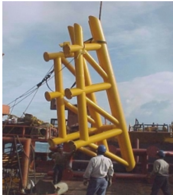
FIGURA No. 63 DEFENSA DE UN DUCTO ASCENDENTE
