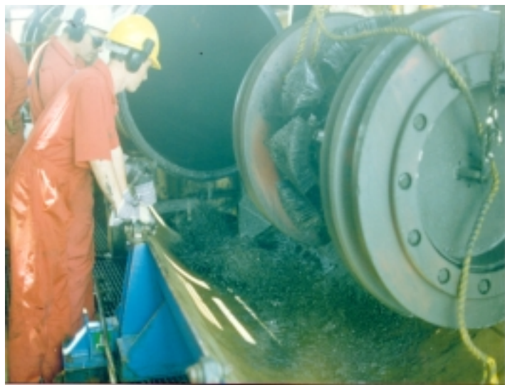
FIGURA No. 83 CORRIDA DE DIABLOS DE LIMPIEZA EN PLATAFORMAS. A LA IZQUIERDA EN MANIOBRAS DE INTRODUCCIÓN A TRAMPA LANZADORA; A LA DERECHA SE OBSERVAN LOS RESIDUOS ARRASTRADOS DURANTE LA CORRIDA.
