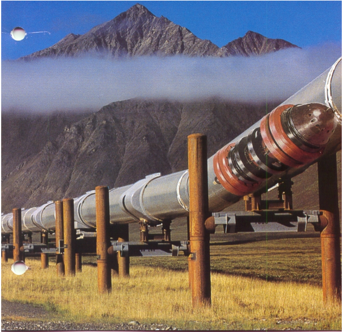
FIGURA No.66 DIABLO INSTRUMENTADO CORRIENDO EN UN DUCTO TERRESTRE
