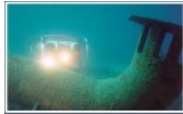
FIGURA No. 91 R.O.V. UTILIZADO PARA EL MONITOREO DE PROTECCIÓN CATÓDICA
